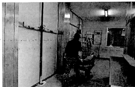
Gli operai al lavoro in Ortopedia per realizzare il passaggio verso il Dea
