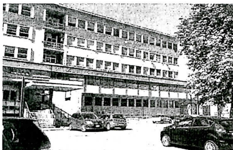
L'intervento è stato eseguito il 24 giugno nei Reparti Speciali
