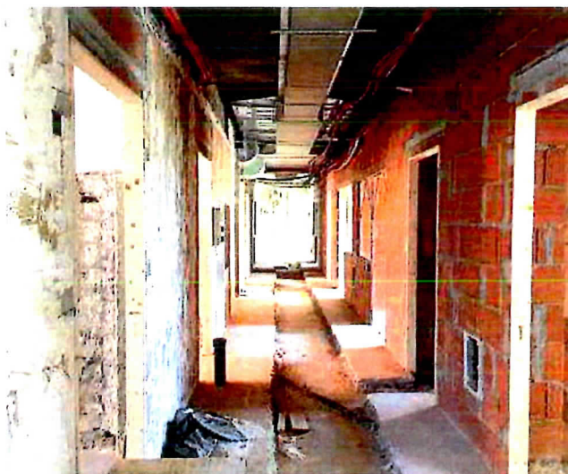
Il corridoio del nuovo reparto trapiantati, 4 stanze a destra e una a sinistra
