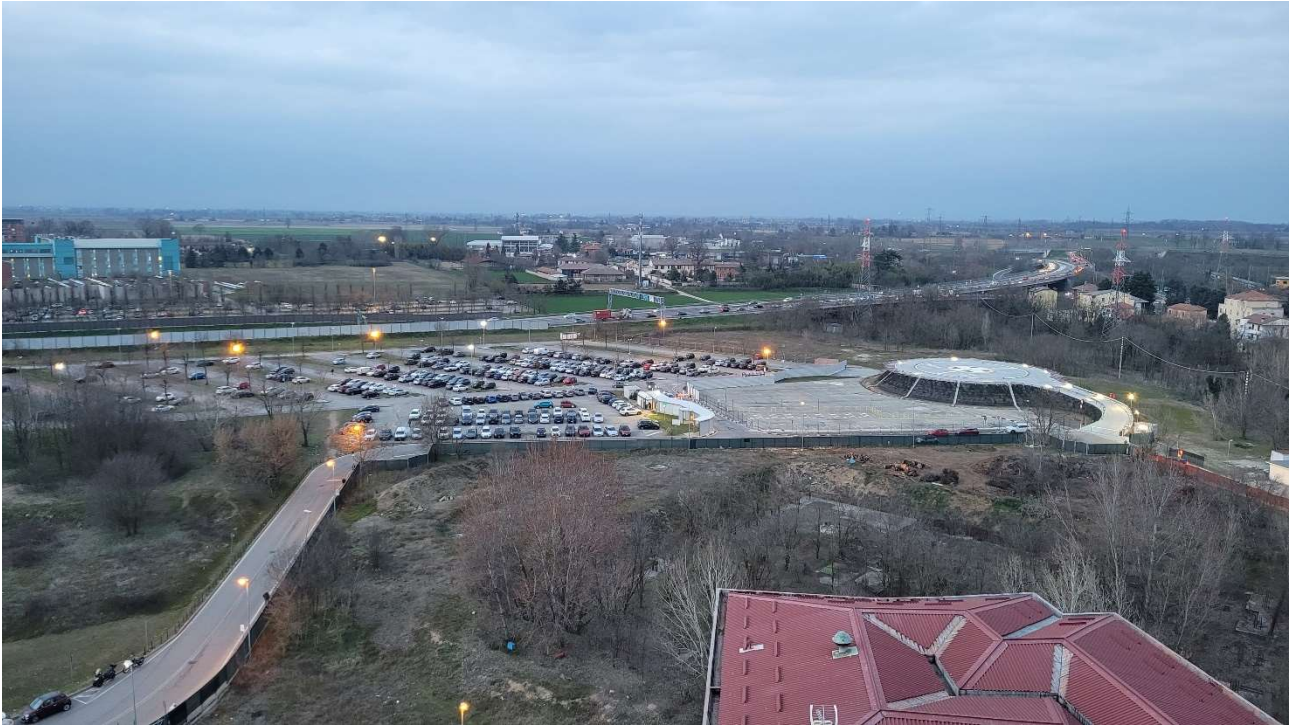
Figura 33 - Vista parcheggio ed elisuperficie
