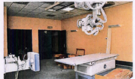
Uno dei locali che ospitano i servizi di diagnostica nel nuovo Dea
